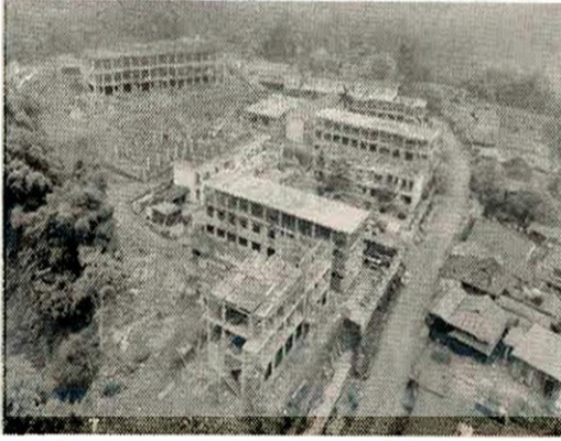
Công trình trường nội trú liên cấp dần thành hình.
